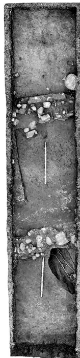
Мал. 9. Манастыр 2019. 3D-мадэль падмуркаў у Шурфах I і III. Малюнак В. А. Макоўскай.
